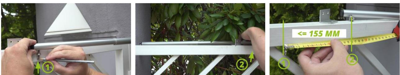
Beträgt der **Abstand dieser beiden Markierungen** rund **155 mm**, ist die Lage des Winkels **optimal**. Ist er etwas **kleiner**, solltest Du den **Abstand B** etwas **erhöhen**. Ist der Abstand **größer als 155 mm**, dann muss der **Abstand B verringert** bzw. ein anderes Montageloch am Winkel 1 gewählt werden.
