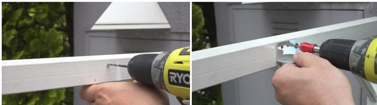
Danach werden die Bohrlöcher markiert und vorgekörnt. Anschließend werden die Bohrlöcher mit dem **4,2 mm Metallbohrer** erstellt. Die Größe des Bohrers ist hierbei entscheidend. Denn bei zu kleinem Durchmesser kann die Schraube abreißen. Bei zu großem Durchmesser hingegen findet die Schraube keinen Halt. Die Fixierung des Winkels erfolgt mit den beiliegenden Edelstahlschrauben.
