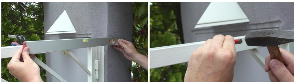
Nachdem der Abstand des zweiten Winkels bestimmt ist, wird jetzt auch die vertikale Position mit Hilfe der Wasserwaage kontrolliert. Denn die Winkel sollten am Ende auch auf selber Höhe liegen.
