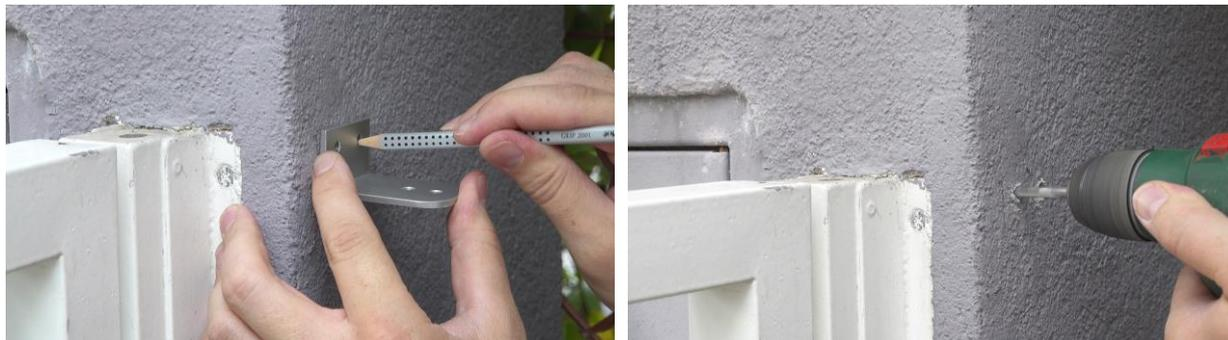
In die Bohrlöcher werden zum Mauerwerk passende Dübel eingesetzt. **Hinweis:** Auf Grund der Vielzahl unterschiedlicher Mauerwerktypen liegen dem Gartentorschließer diese Materialien nicht bei.
