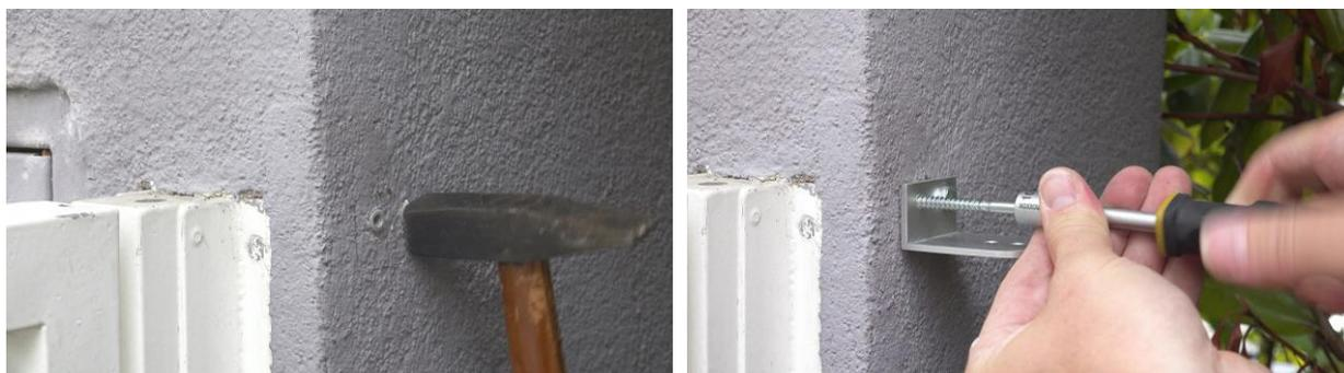
Nach dem Einsetzen der Dübel wird der Winkel mit passenden Schrauben fixiert. Die Schrauben sollten dabei immer 10 mm länger ausfallen als die Dübel. Denn nur dann werden die Schrauben sicheren Halt finden.
