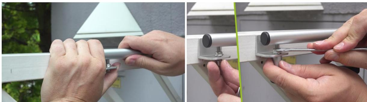
Zum Schluss werden die beiden Hutmuttern aufgeschraubt und der Gartentorschließer mit den Kontermuttern fixiert. Die Muttern sind dabei **so fest zu ziehen**, dass sich die Gewindestangen aufrichten und **im rechten Winkel** zum Montagewinkel stehen.
